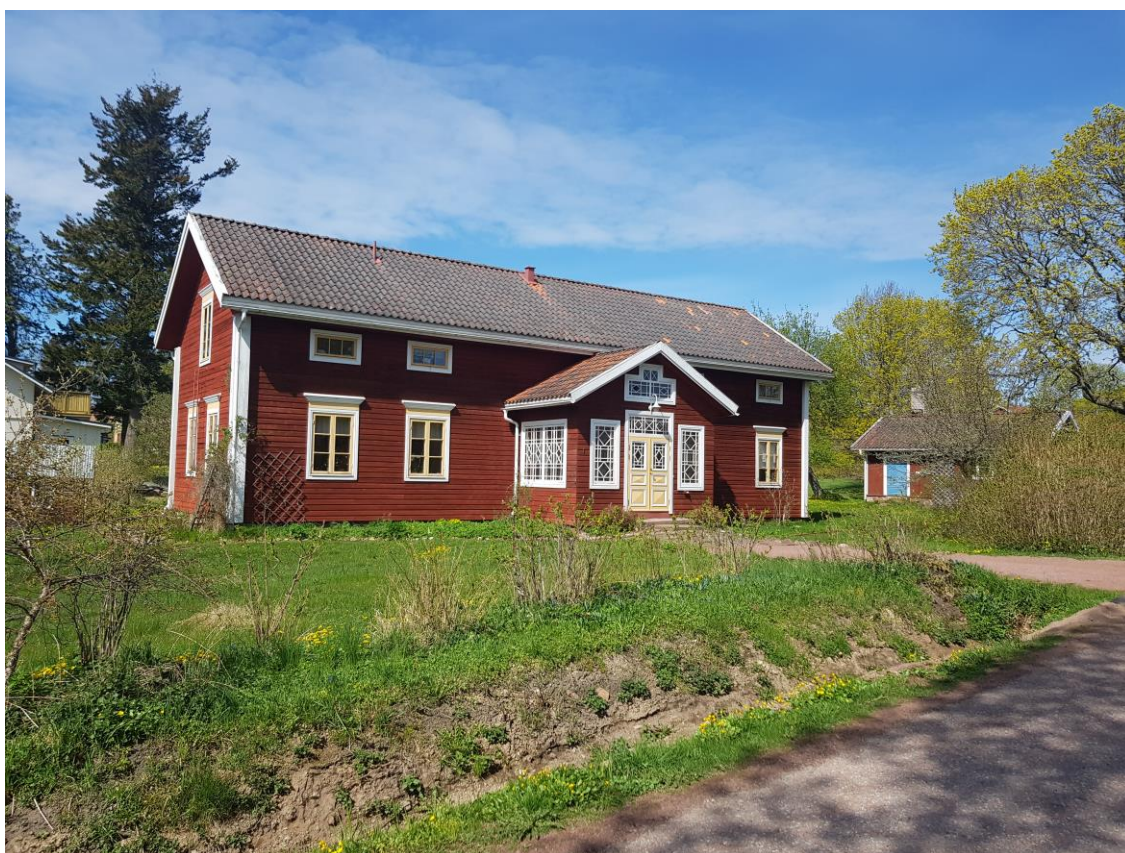
Bild 5: den ståtliga huvudbyggnaden på fastighet Hagelund 5:5
