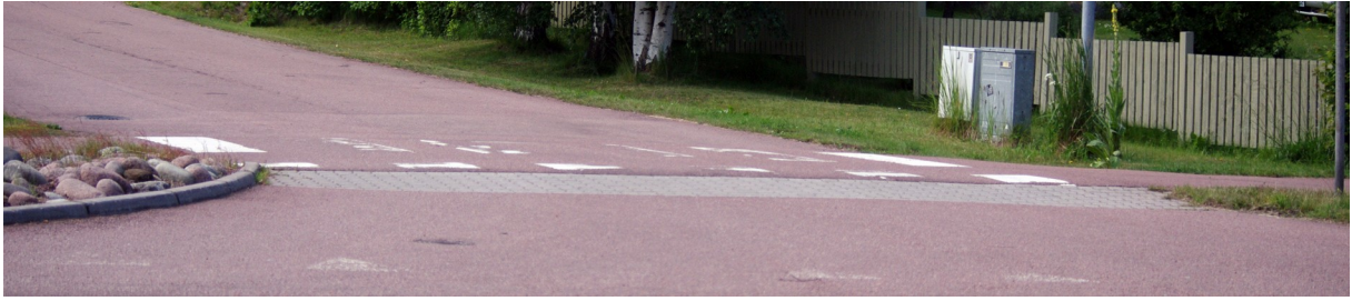
Exempel på gatudetaljer – upphöjd gc-led i korsning med motorled
